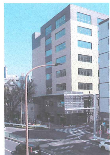
新センターの外観(R3.3.23撮影)
